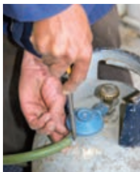
شکل ۱-۶۶ ب سفت کردن بست
